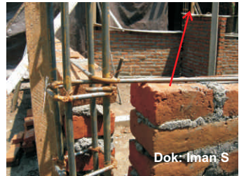
Foto pertemuan dinding dengan Kolom
