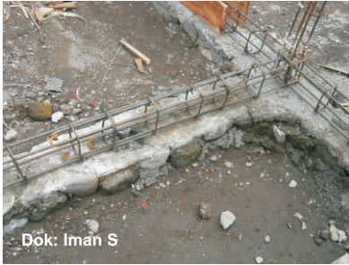
Foto sambungan Kolom dan balok pengikat/sloof
