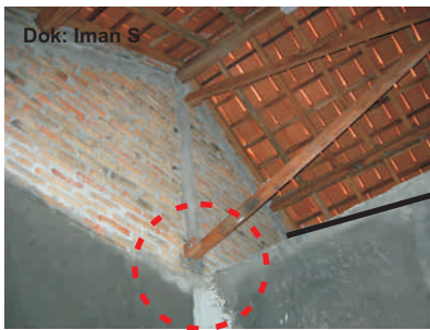
Foto pertemuan ikatan angin dengan gunung gunung
