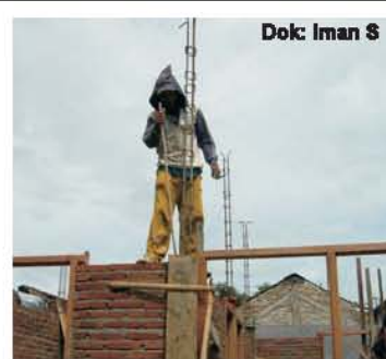
Pengecoran pertama setinggi 1 m
