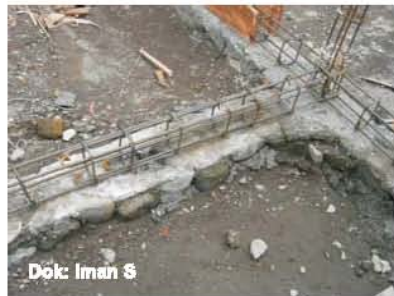
Foto sambungan Kolom dan balok pengikat/sloof
