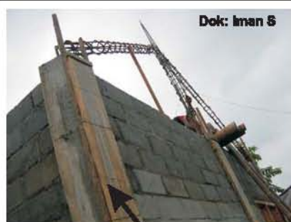
Pengecoran pertama setinggi 1 m
