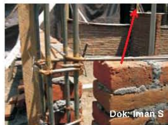
Foto pertemuan dinding dengan Kolom
